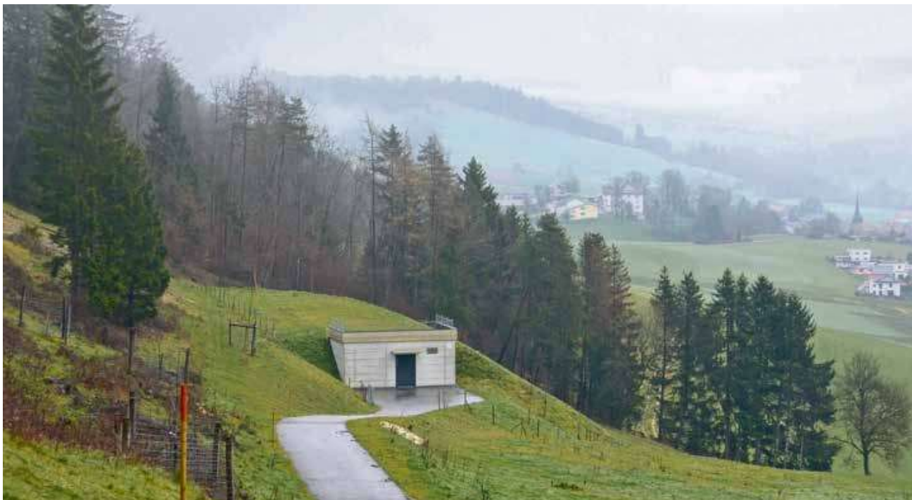
Le SEAUCC va installer une alimentation électrique de secours, afin que la manutention à distance de la vanne incendie soit garantie même en cas de coupure du réseau
